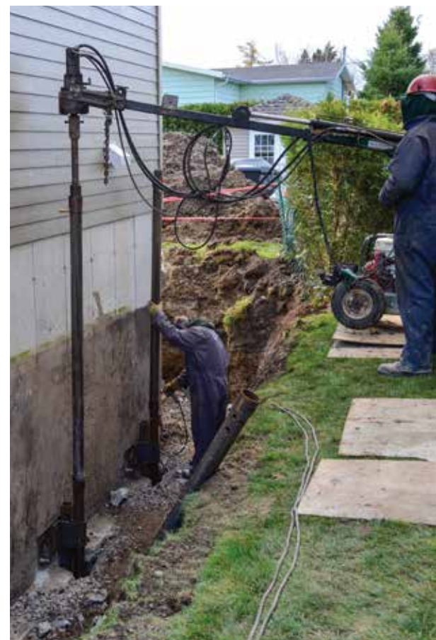
Pour la technique des pieux vissés, un étrier est placé sous la semelle de la fondation pour y insérer le pieu. Le pieu est ensuite enfoncé dans le sol par vissage, grâce à un équipement spécialisé.
